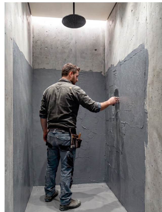
IMPERMEABILIZZAZIONE DI UNA DOCCIA CON NORTIG 15 FIBRATO
