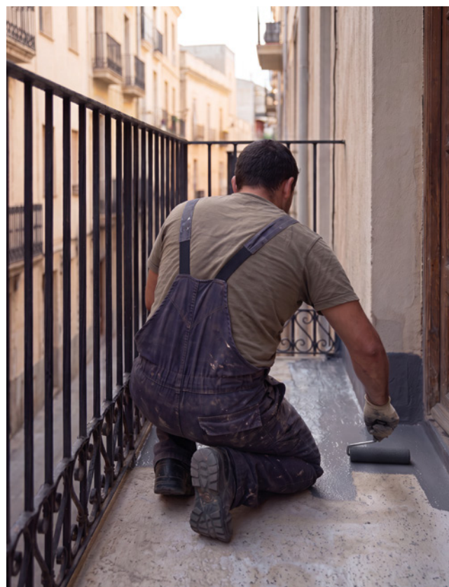
IMPERMEABILIZZAZIONE DI UN BALCONE
