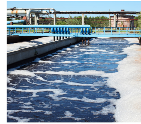
ACQUA CORROSIVA E INQUINATA
