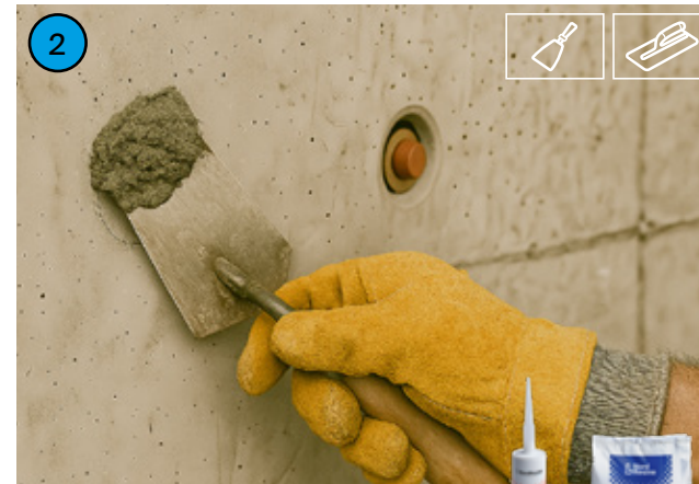
Uszczelnij dystanseza pomocą BETONSEAL MS 2.0 i wypełnij za pomocą MALTAFIX TR4.
