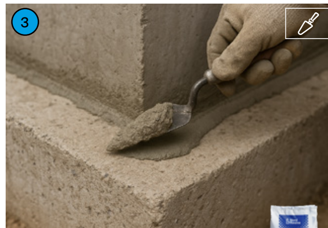
Wykonaj fasetę między pionem i poziomem za pomocą MALTAFIX TR4.
