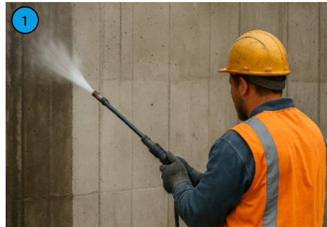
Ciśnieniowe mycie podłoża.
