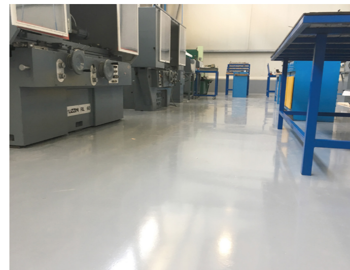
↑ rivestimento epossidico realizzato con NORPHEN 300 applicabile a rullo in due mani su supporto trattato con levigatura a diamante e una mano di FONDO SL.
