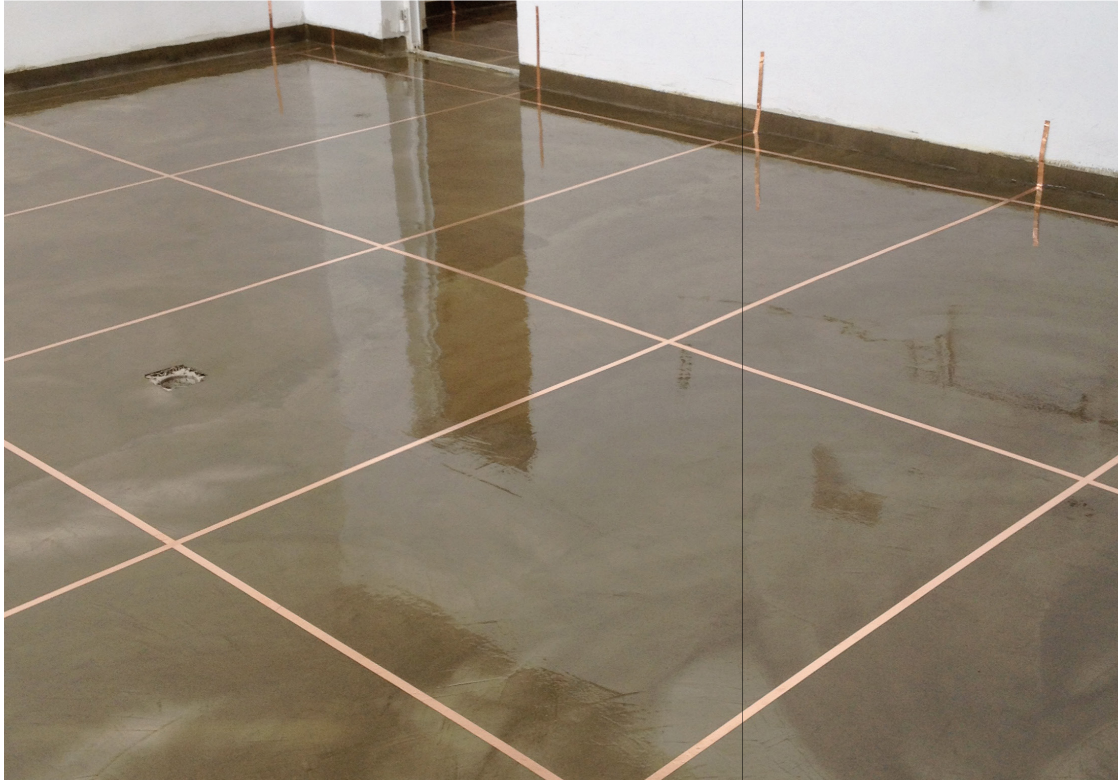
↑ Rivestimento epossidico antistatico/conduittivo specifico per ambienti a norma IEC 61340 realizzato con il sistema ESC.
