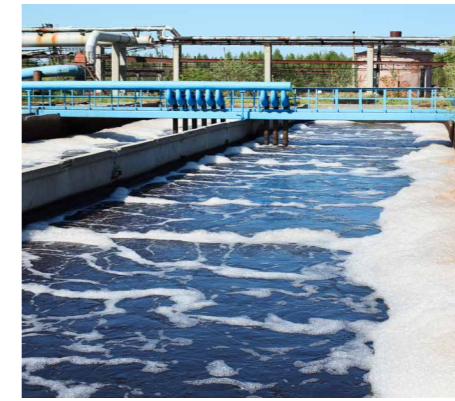
ACQUA CORROSIVA E INQUINATA
