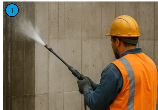
Idrolavaggio del supporto.
