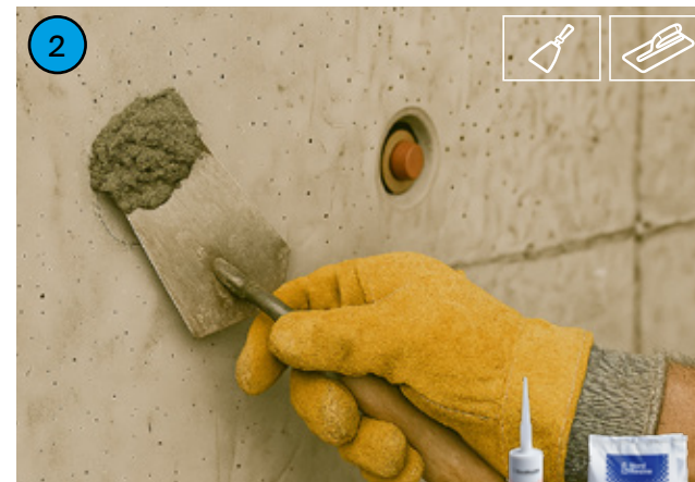
Taglio dei distanziatori, sigillatura con BETONSEAL MS 2.0 e stuccatura con MALTAFIX TR4 .
