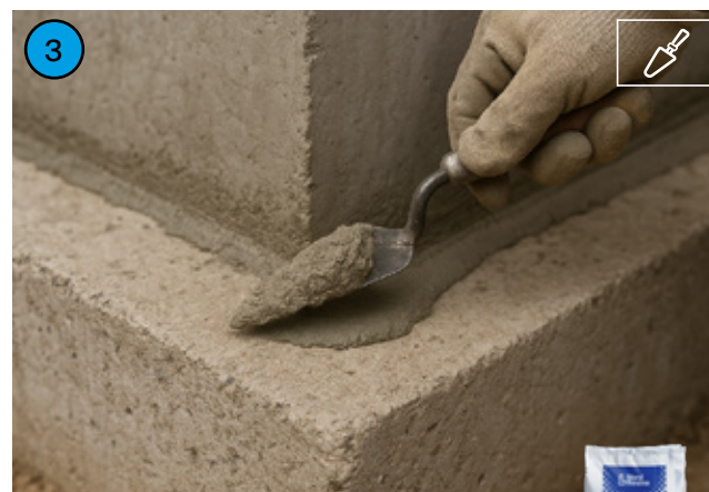
Realizzazione di guscia tra verticale ed orizzontale con MALTAFIX TR4 .
