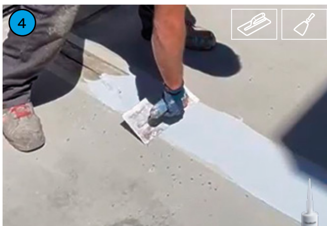
4 Sigillatura dei giunti di contrazione con BETONSEAL MS 2.0 .
