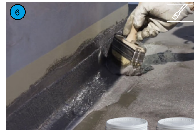
6 Impermeabilizzazione dei risvolti verticali a pennello, armata con NYCON F .
