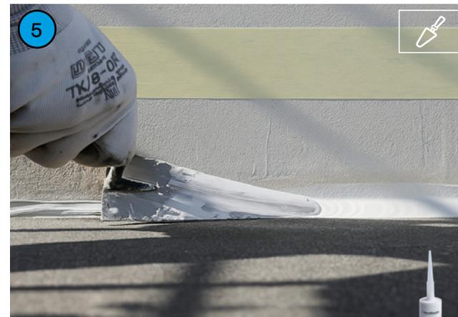
Sigillatura dei giunti perimetrali: guaina continua con **BETONSEAL MS 2.0** e **A FRESCO** applicazione di Betonguaina (fig. 6).
