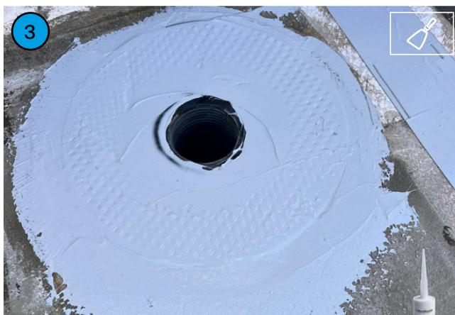
Posizionamento degli scarichi e sigillatura con **BETONSEAL MS 2.0**.
