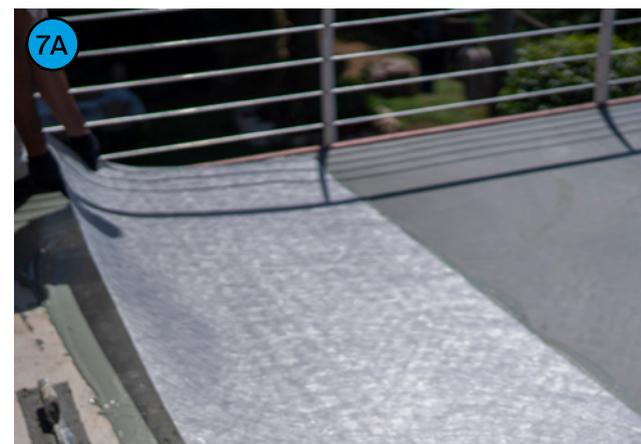
Impermeabilizzazione della superficie orizzontale: **BETONGUAINA** o **BETONGUAINA.S** applicata a spatola in mano unica, armata con **NYCON 100** o **NYCON 200** annegata nello strato di Betonguaina. Sormontare i tessuti **NYCON** di almeno 5 cm.
