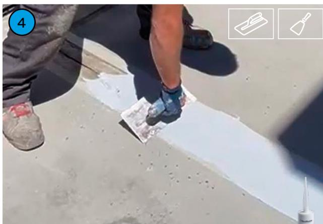
Sigillatura dei giunti di contrazione con **BETONSEAL MS 2.0**.
