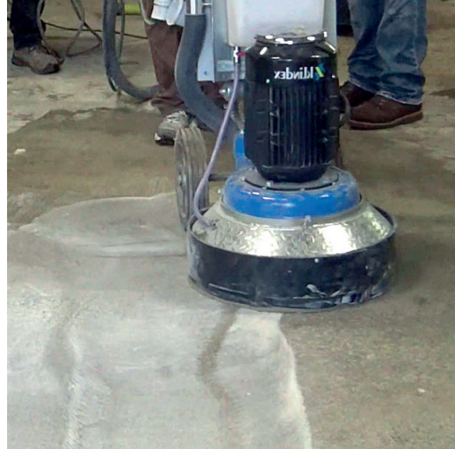
RIPRISTINO E PREPARAZIONE DEI FONDI
