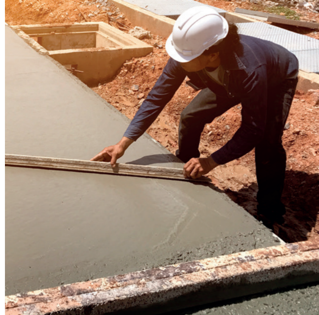
RIPRISTINO E PREPARAZIONE DEI FONDI
