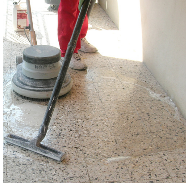
RIPRISTINO E PREPARAZIONE DEI FONDI
