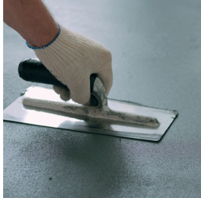
RIPRISTINO E PREPARAZIONE DEI FONDI
