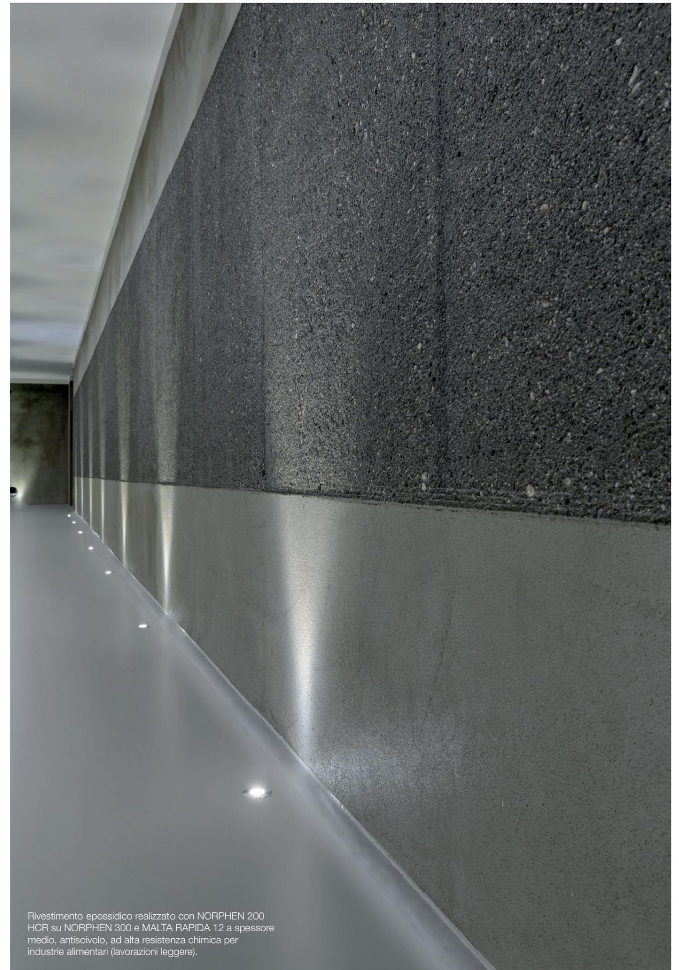
Rivestimento epossidico realizzato con NORPHEN 200 HCR su NORPHEN 300 e MALTA RAPIDA 12 a spessore medio, antiscivolo, ad alta resistenza chimica per industrie alimentari (lavorazioni leggere).
