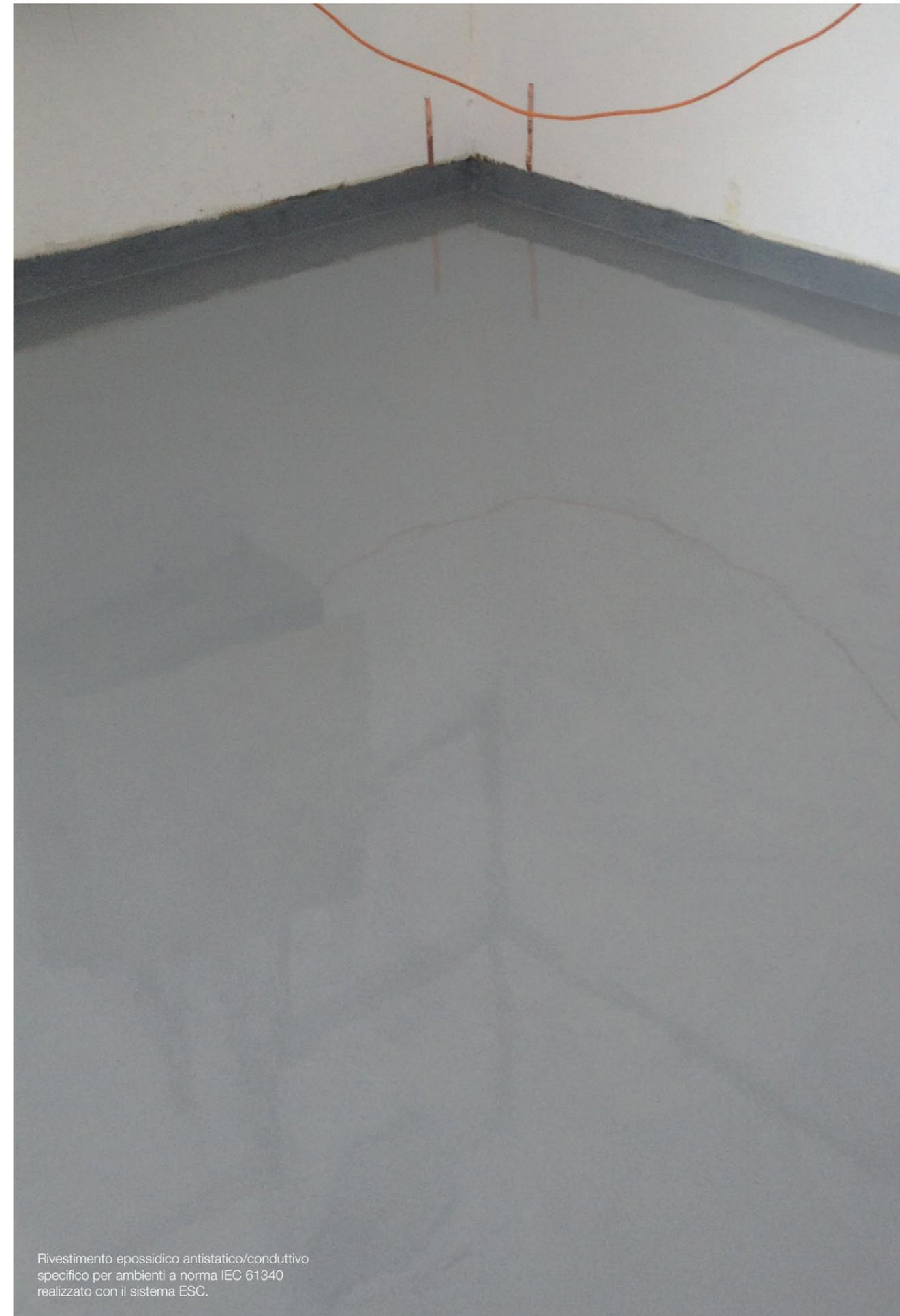
Rivestimento epossidico antistatico/conduittivo
