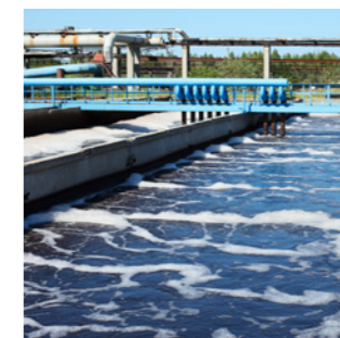
ACQUA CORROSIVA E INQUINATA
