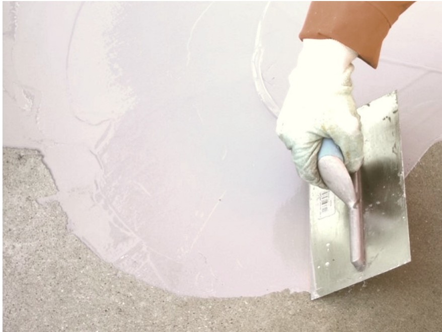
Rysunek 2 - Wygładzanie betonu.
