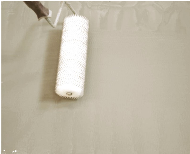
Rysunek 4 — Użycie rozbijacza pęcherzyków powietrza przy nakładaniu drugiej warstwy.
