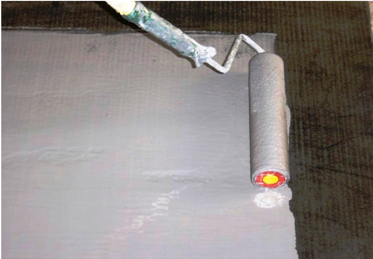
Figura 1 - Applicazione a rullo su guaina bituminosa.
