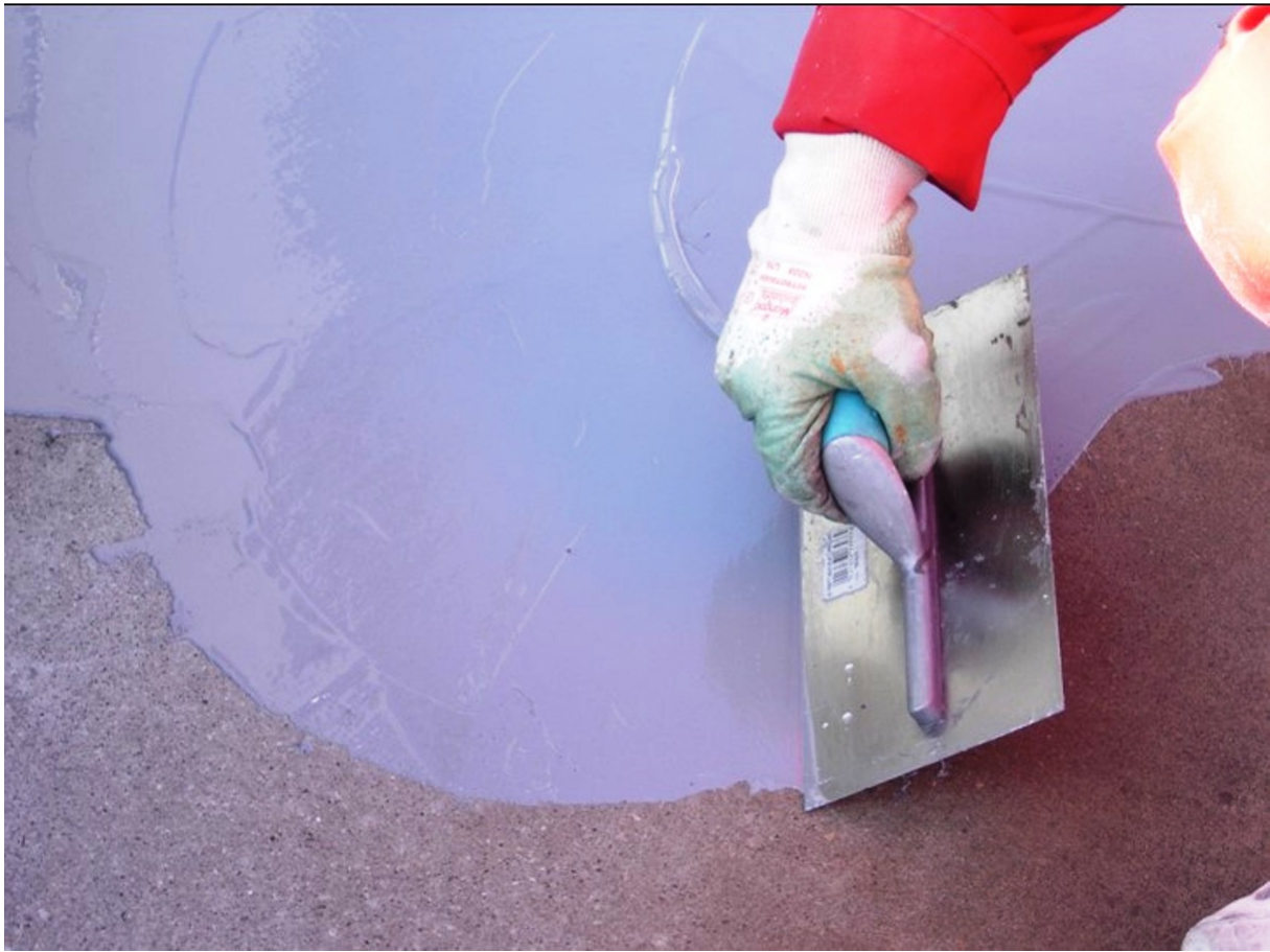
Figura 2 - Rasatura su calcestruzzo.
