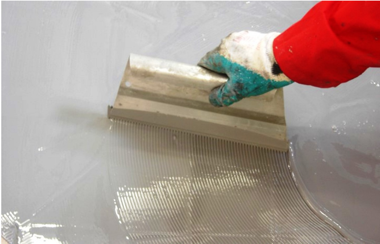
Figura 3 - Applicazione della seconda mano di EASY-LAST 901.
