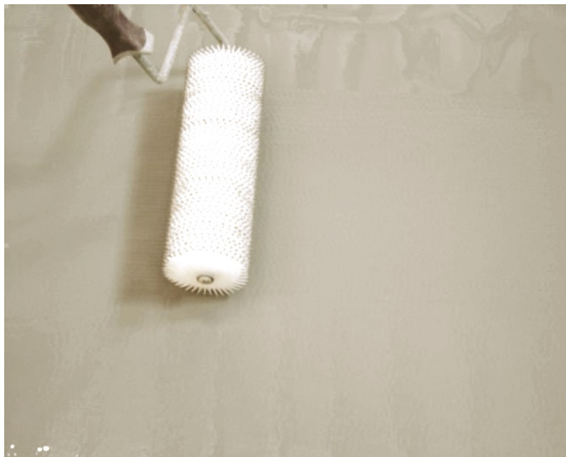
Figura 4 - Utilizzo del frangibolle sulla seconda mano.
