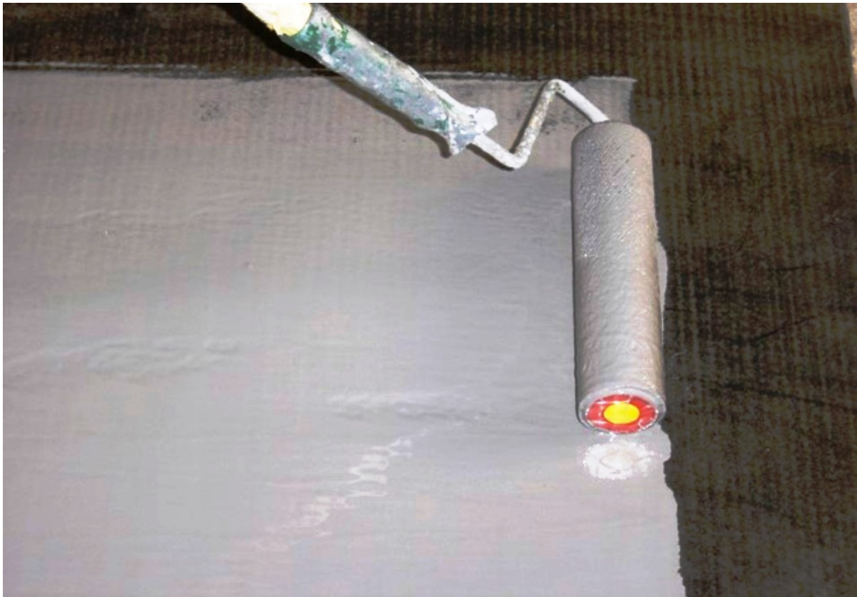
Figura 1 - Applicazione a rullo su guaina bituminosa.
